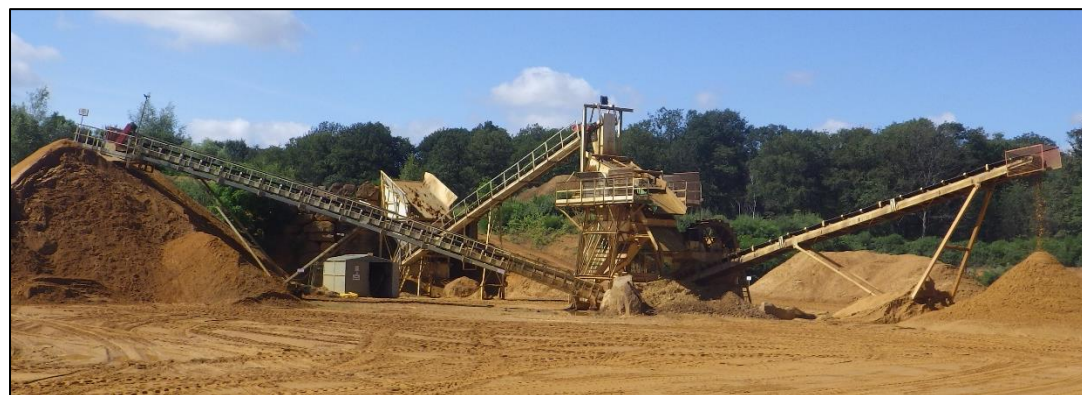
Photo 5 : Installation fixe de traitement de la carrière
