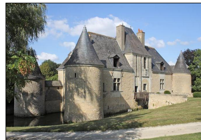
Photo 18 : Façade Sud du manoir de la Cantinière
