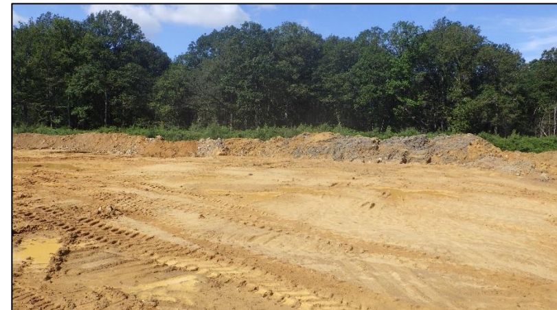
Photo 15 : Panneau indiquant les déchets acceptés dans la benne déchet industriel banal (DIB) Photo 16 : Plateforme de remblayage de matériaux inertes extérieurs, au Nord de la carrière
