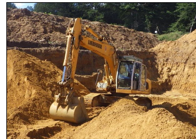
Photo 4 : Pelle hydraulique utilisée sur la carrière
