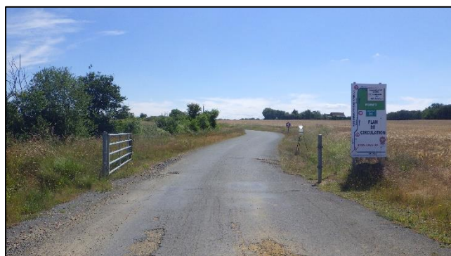
Photo 6 : Début de la voie d'accès enrobés et munie d'un portail verrouillable
