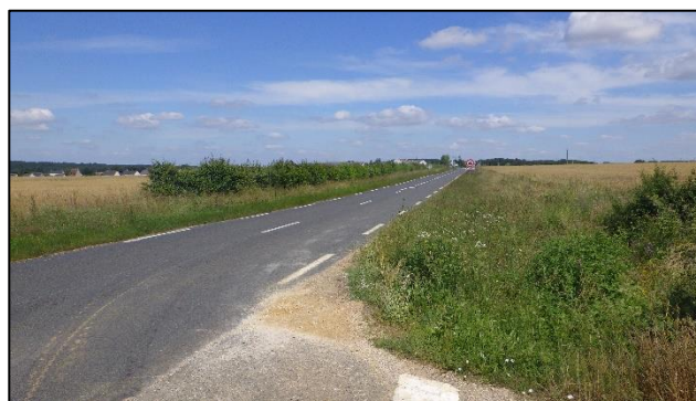
Photo 8 : Vue depuis la sortie de la voie d'accès en direction de Louestault
